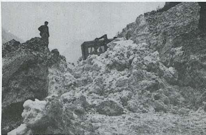
UN ASPETTO DEL TITANICO LAVORO COMPIUTO SULLA STRADA DI VAL RACCOLANA DALLE MACCHINE DELL'ING. NOGARA DI CAVE DEL PREDIL, PER LO SGOMBERO DELLA NEVE. UN «BULLDOZER» SI APRE LA VIA A STENTO FRA UNA VALANGA «DI TERRICCIO E NEVE» CHE BLOCCA UNA CURVA DELLA STRADA POCO PRIMA DI SALLA NEVEA
