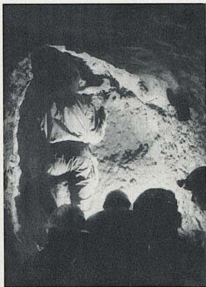
I lavori di disostruzione foto C.G.E.B.
