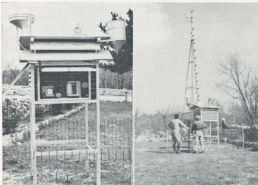
La dotazione strumentale della capanna meteorologica
