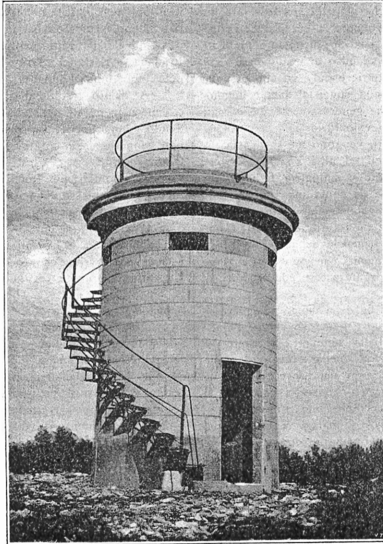
VEDETTA ALICE (452 m.) presso il varco di Trebiciano inaugurata addì 29 giugno 1897.
